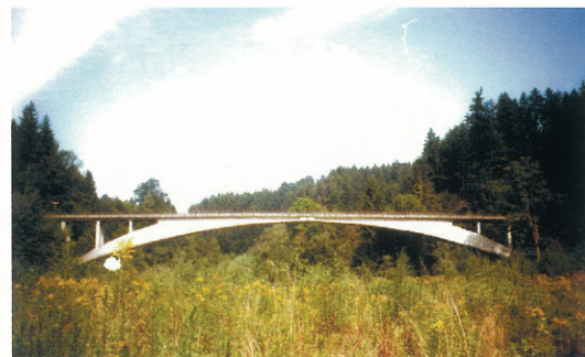
(写真-4) ロス グラーベン橋
