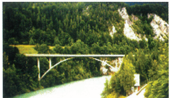
(写真-10) 受け継がれた版アーチ橋
